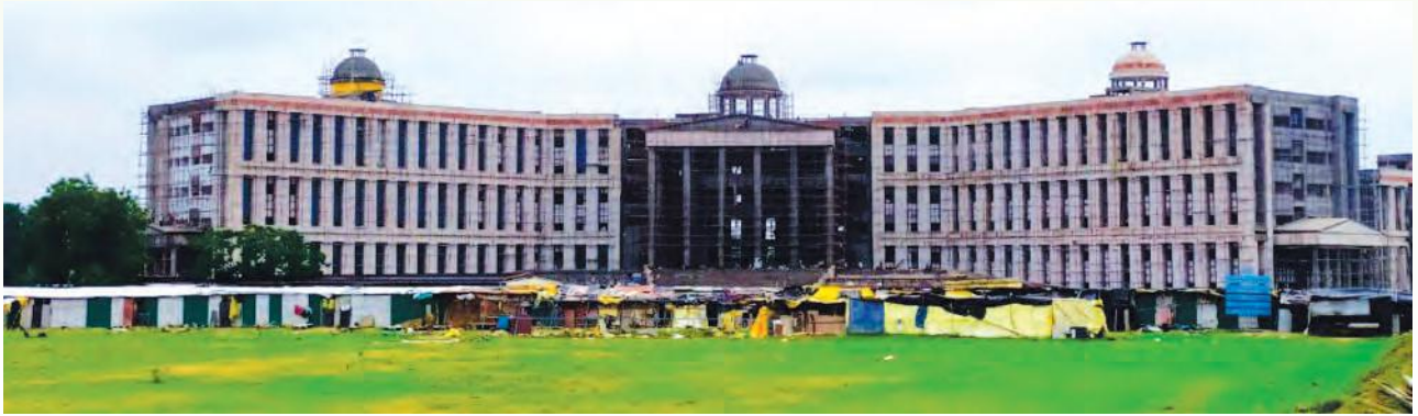
निर्माणाधीन शैक्षणिक प्रखंड
