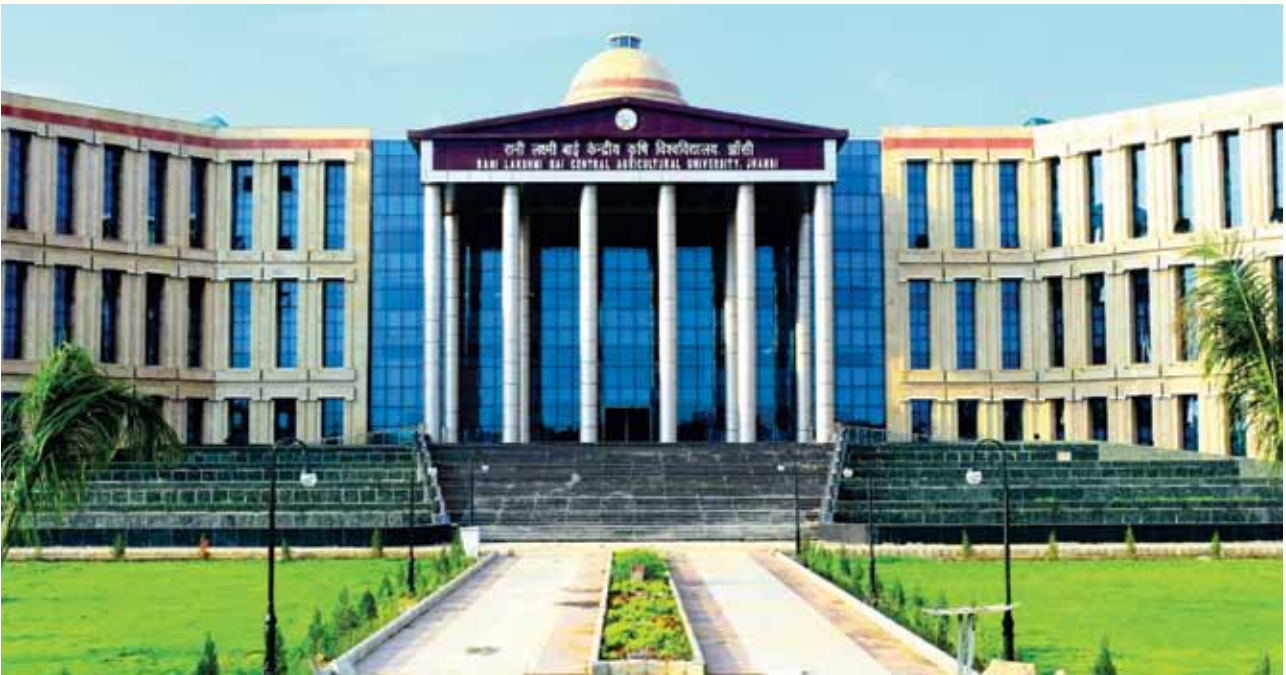
नवनिर्मित शैक्षणिक भवन की झलक
