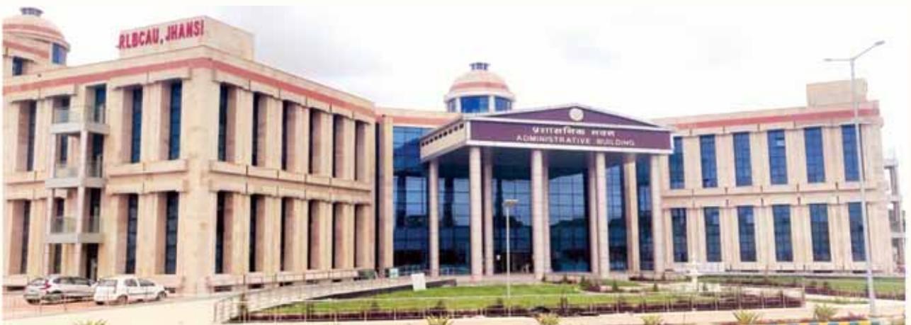
नवनिर्मित प्रशासनिक भवन
